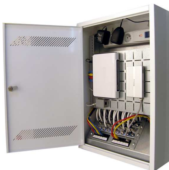
Podłączona rozdzielnia. Dodatkowo zamontowany router ze switchem na 4 porty i twardy dysk (IP) jako archiwum ftp
